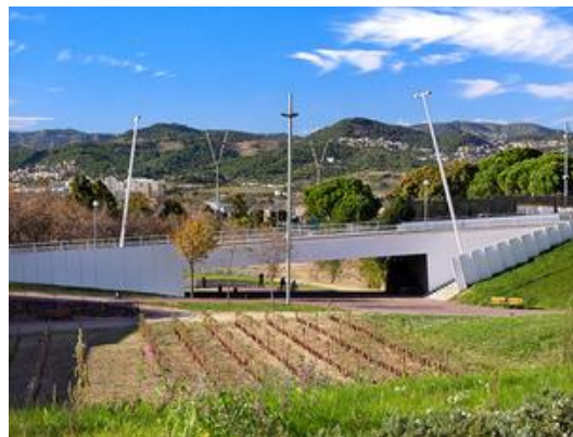
Imatge 8. Pont del Marquès de Monistrol
