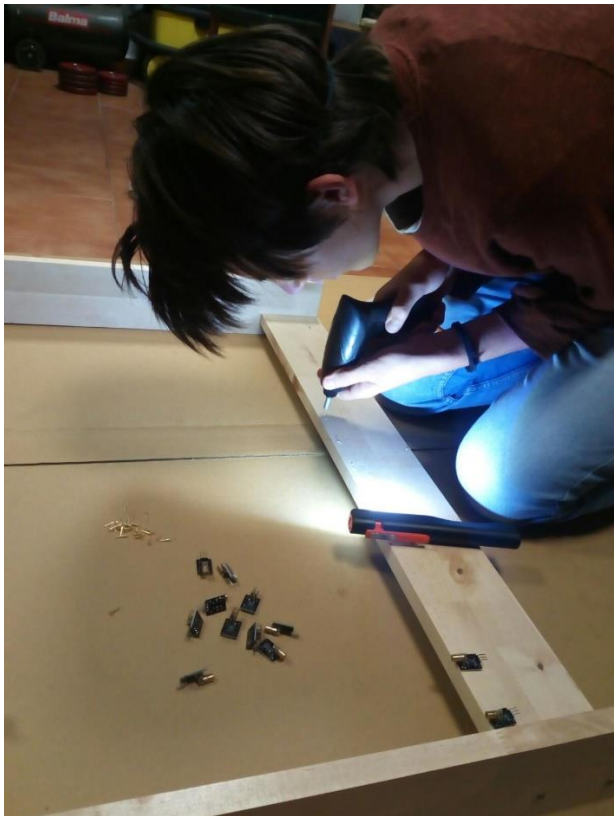
Figura 17: Foradant la fusta per a la col·locació dels làsers
