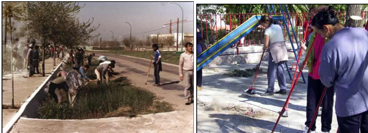
Dues de les fotografies dels anomenats Domingos Rojos : A l'esquerra, treballant en la urbanització d'un passeig, a la dreta, les dones netejant l'escola.
