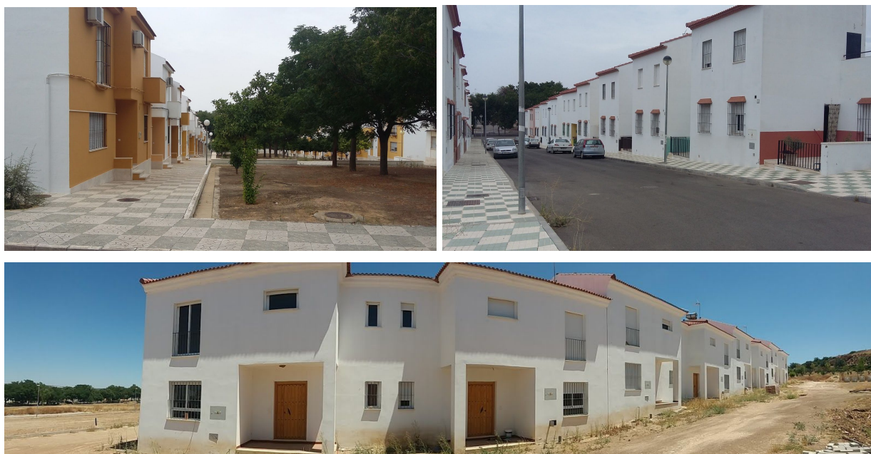
Tres fotografies de cases d'autoconstruïció. A dalt, dos carrers de cases d'autoconstruïció de les últimes promocions. A baix, última promoció de cases recent acabades, faltava pavimentar el carrer i ja es podrien habitar. Aquesta última promoció gaudirà d'un servei de plaques solars.
