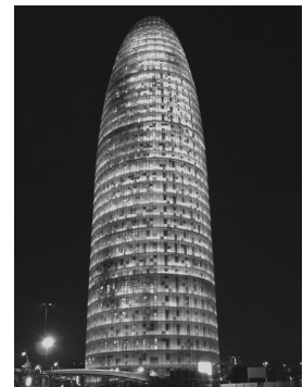
La torre Agbar de Barcelona és un enorme panell de LED (Light Emitting Diodes, diodes emissors de llum) que forma part de la Vista del programa que la controla.
