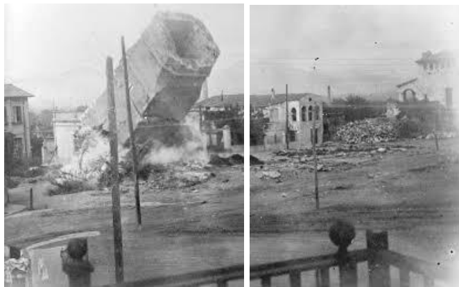
Enderrocament del campanar de l'església Santa Maria.
