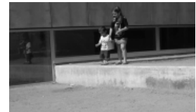
Desnivell d'un pati escolar sense protecció. Una tanca evitaria el perill o risc de caigudes.
