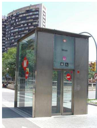
FIGURA 2.16. Ascensor de vidre
