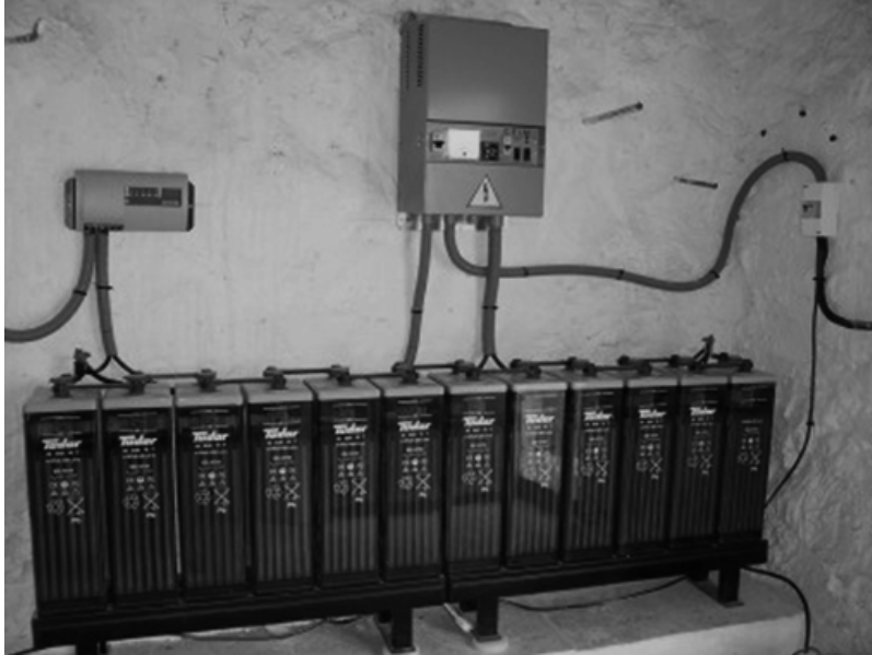
FIGURA 1.7. Instal·lació inadequada del regulador i l'inversor en una instal·lació fotovoltaïca autònoma
