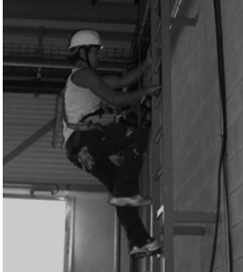
Operari amb l'equipament bàsic de protecció personal
