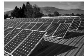
Estructures muntades sobre coberta sandvitx
