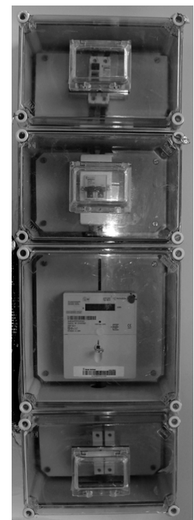
Punt de connexió d'una instal·lació monofàsica
