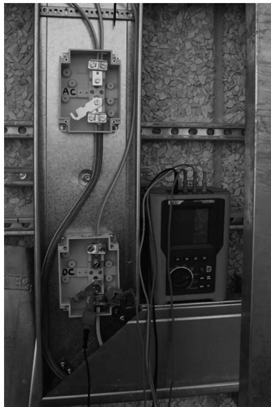
FIGURA 1.14. Mesura de la resistivitat del terra d'una instal·lació fotovoltaïca
