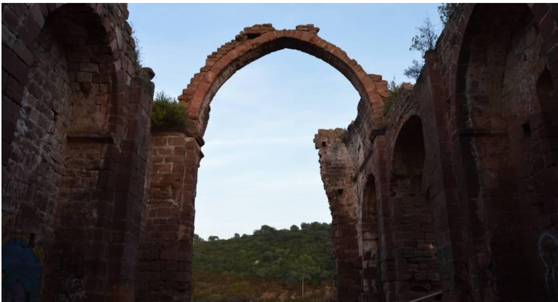
Il·lustració 32 Vista de l'interior de l'església on veiem l'arc que encara s'hi conserva. Font: pròpia.
