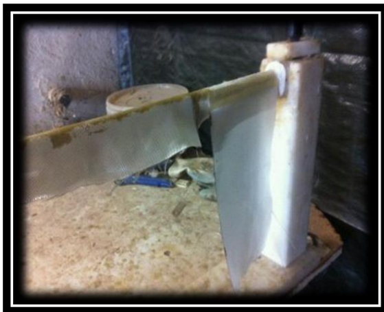
Cobrint l'estic amb un tipus de fibra
