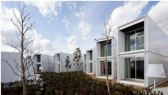
Figura 65: Byside Marina, mòduls de doble altura en aparent desordre
