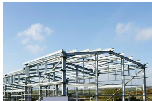
Figura 7: Estructura feta en metàl·lica
