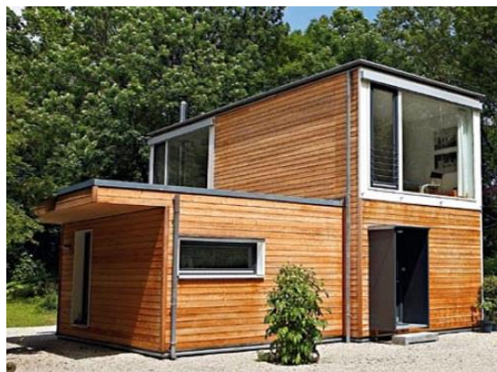
Figura 54: Exemple d'arquitectura modular en fusta
