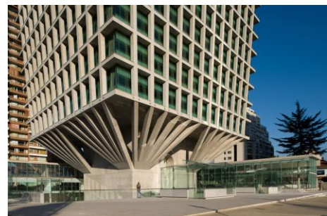
Figura 8: Estructura de formigó
