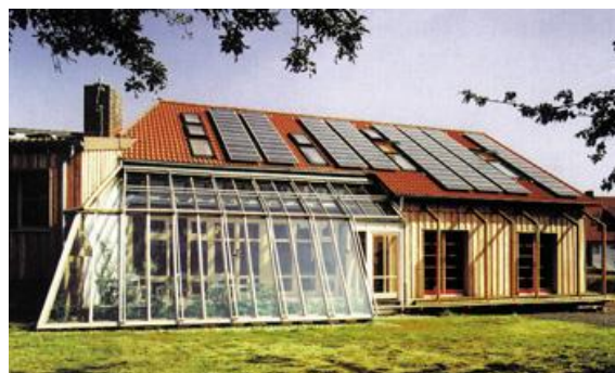
Figura 28: Vivenda amb annex envidrat que permet l'entrada de llum i radicació solar però no en deixa sortir l'escalfor.
