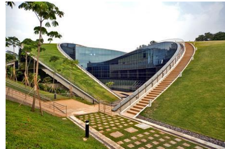
Figura 29: Coberta enjardinada d'un edifici com a regulador tèrmic i acústic
