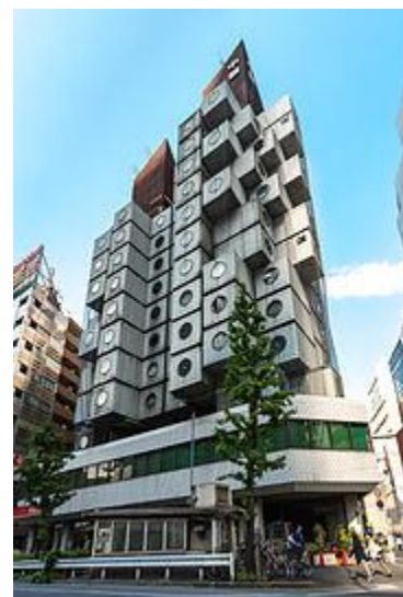
Figura 53: Capsule Tower de l'arquitecte Kisho Kurokawa
