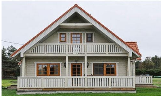
Figura 14: Casa amb tancaments de fusta
