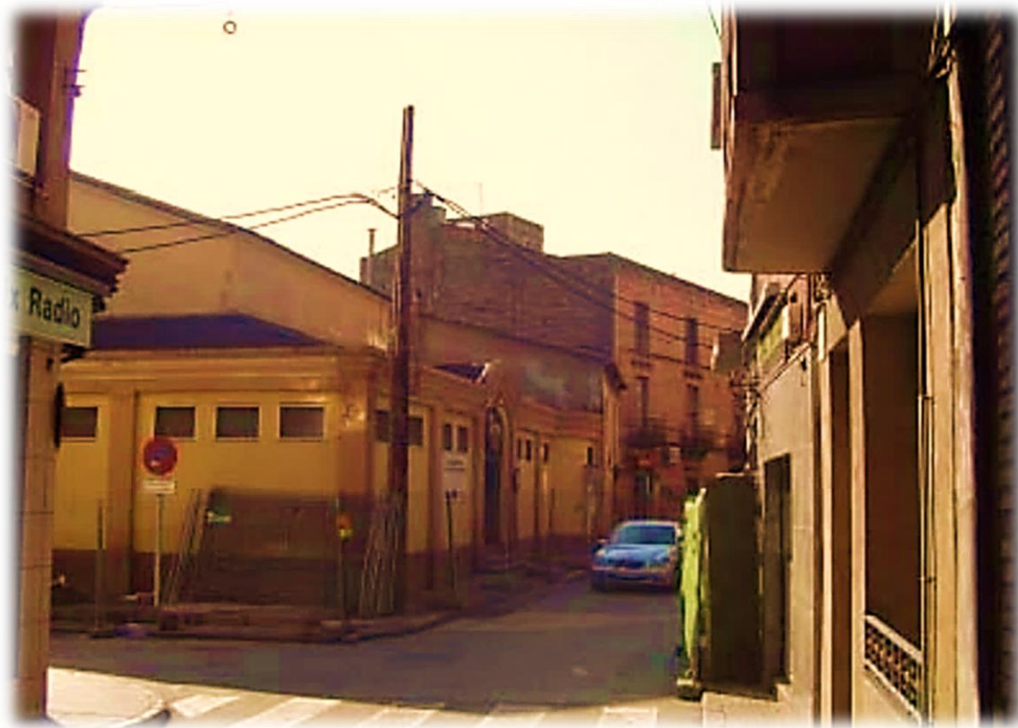
Mercat Municipal abans de ser derruït Foto: memòria intervenció
