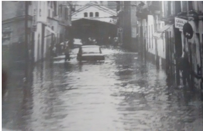
Barri Riera després de la Riuada.
