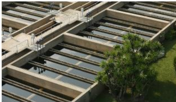
IMATGE 31: PISCINES DE SEDIMENTACIÓ I DECANTACIÓ
