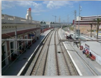
Estació de Rodalies RENFE de Cornellà de Llobregat
