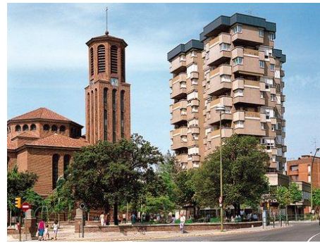
Plaça de l'església, barri centre.
