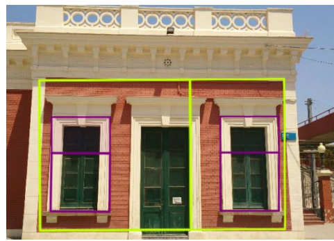
Els blocs laterals de l'estació RENFE contenen la proporció àuria tant al frontal com a les finestres.
