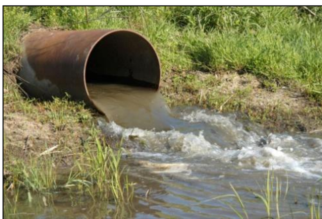
Figura 2: Abocament d'aigües residuals urbanes.
