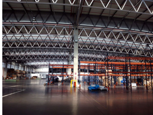
FIGURA 3.1. Interior del magatzem central de l'aeroport de Barcelona
