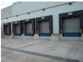
Els molls de càrrega i descàrrega de camions s'adapten a l'alçària i dimensions per tal que el procés de càrrega i descàrrega sigui més eficient i segur.
