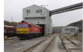
Procés de càrrega de granel per la part superior del tren utilitzat en indústries mineres.
