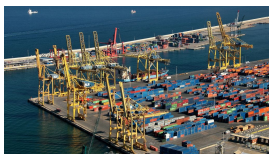
Zona de càrrega i descàrrega i dipòsit de la terminal de contenidors del port de Barcelona.
