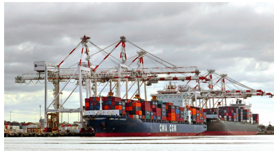
FIGURA 2.1. Terminal de contenidors
