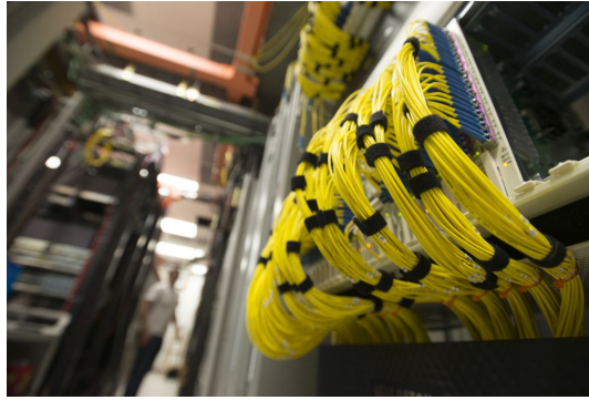
FIGURA 3.2. Farcells de cablejat units per una brida
