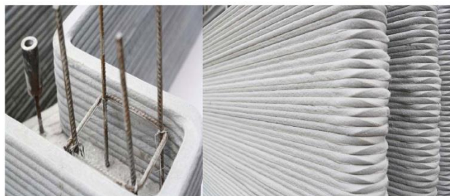
Estructures internes d'elements de construcció creades per tecnologia 3D.
