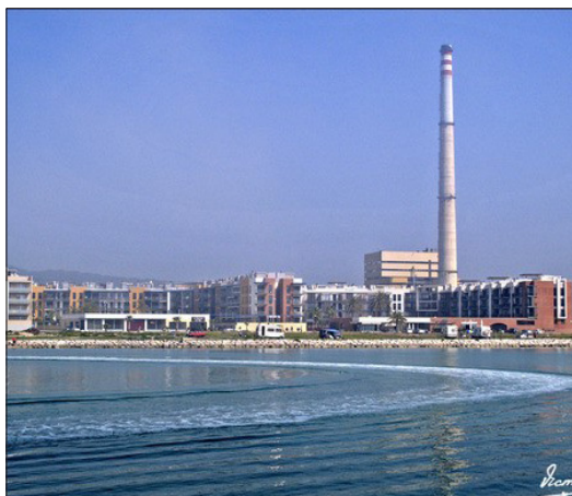
Figura 1. Central de Cubelles (actualment en funcionament)
