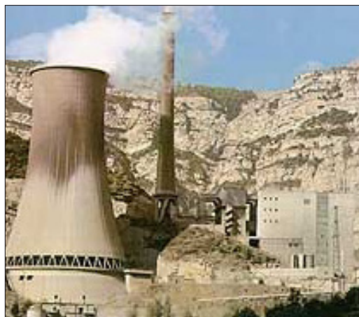
Figura 2. Central de Cercs (tancada el 2011)
