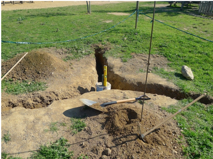
Figura 31 Emplaçament excavat abans d'encimentar
