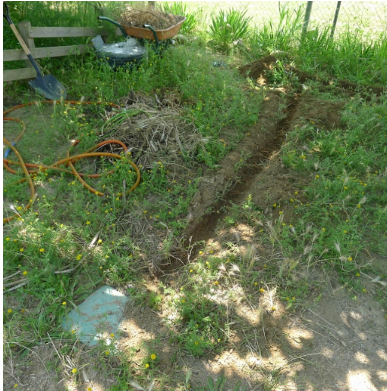
Figura 41: Unió amb el reg automàtic, que queda protegit sota la tapa verda.
