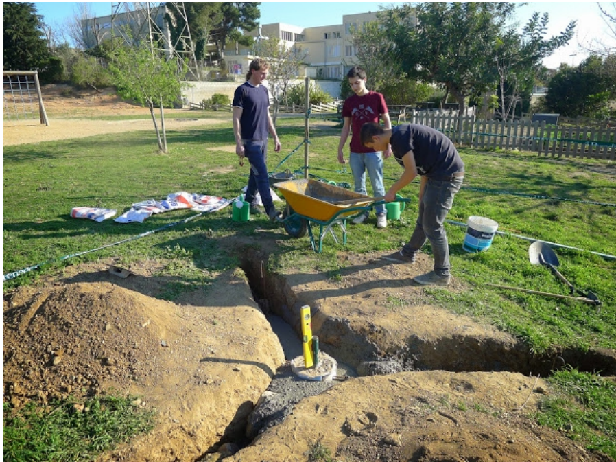
Figura 33: Encimentant l'emplaçament
