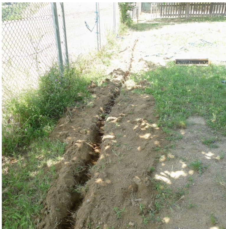
Figura 40: Lloc per on passaria el tub amb el cable de coure
