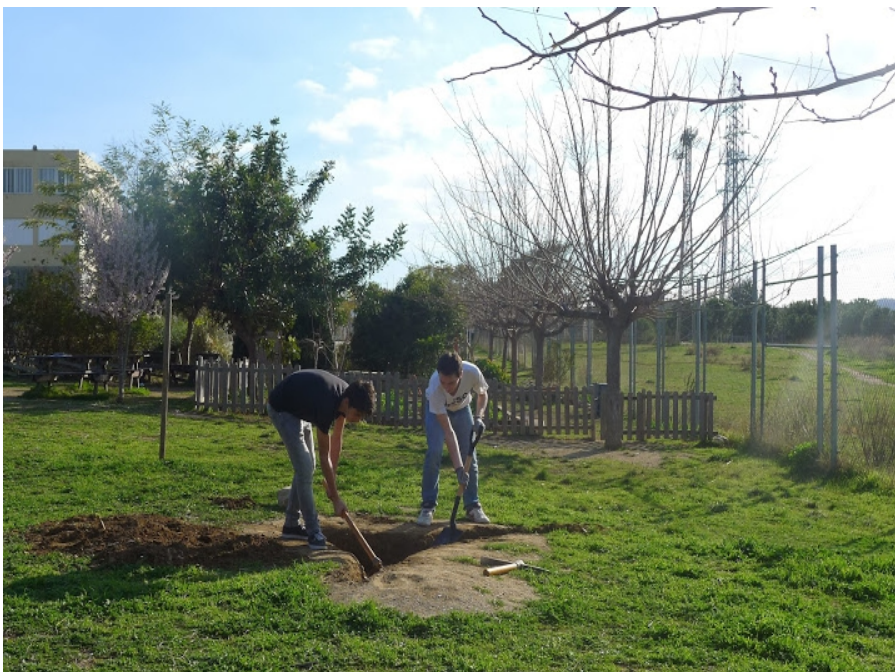
Figura 30: Cavant la terra per posteriorment omplir amb ciment
