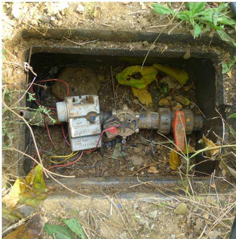
Figura 42: Temporitzador connectat al pas de l'aigua del reg.
